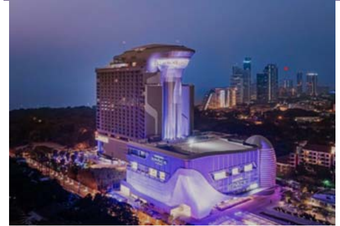
Figure 8: ภายนอกโครงการ
