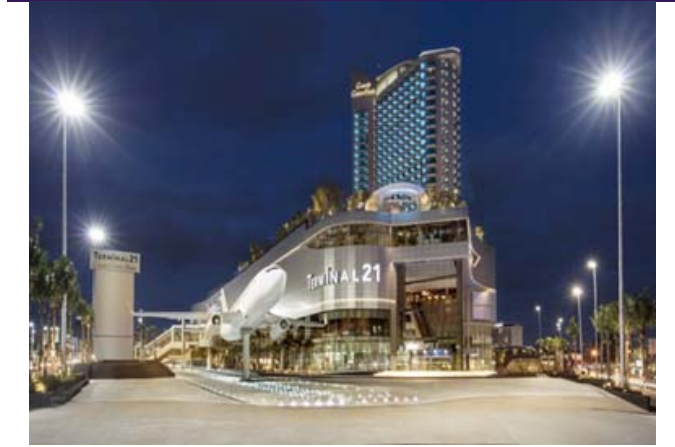
Figure 10: ภายนอกโครงการ
